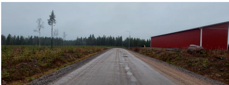
Katunäkymä Rokulinmäentieltä pohjoiseen. Oikealla PHM -Urakointi Ky:n rakennuksia, vasemmalla rakentamattomia teollisuustontteja.
