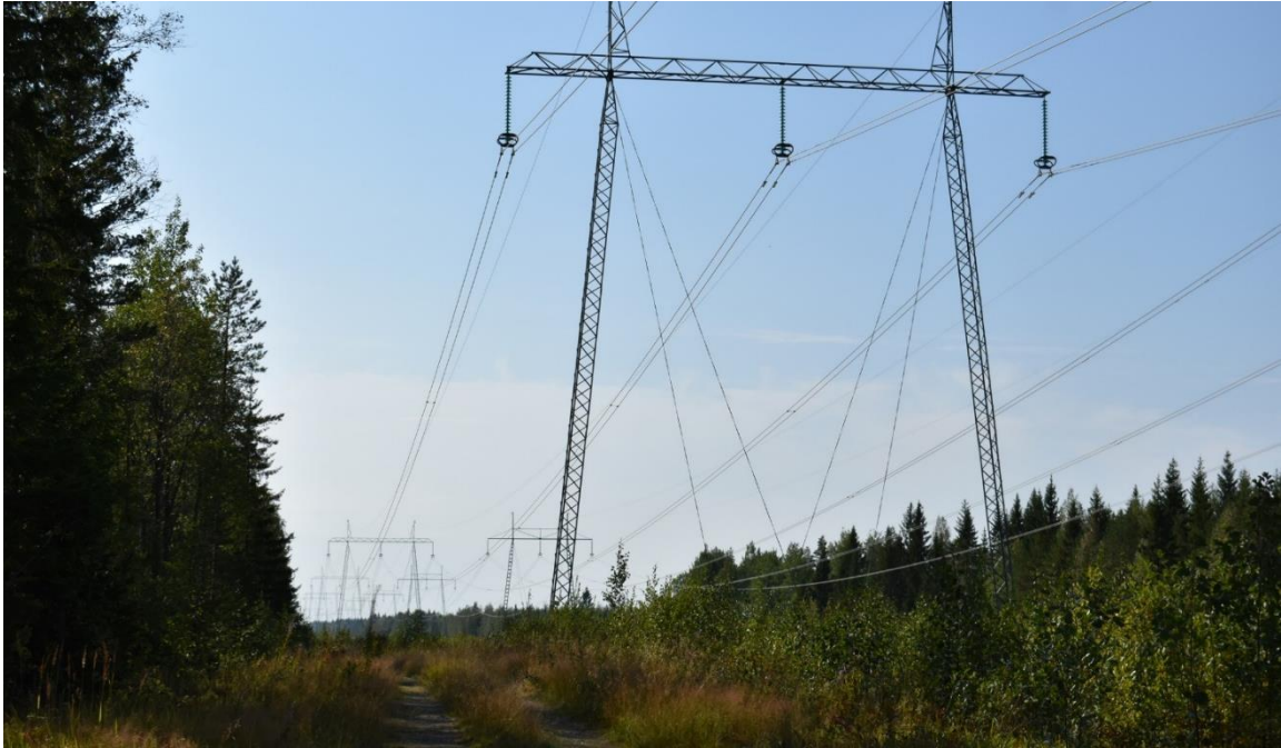
Kuva 12. Hankealueelle sijoittuu Fingridin 2 x 400 kV voimajohtokäytävä
